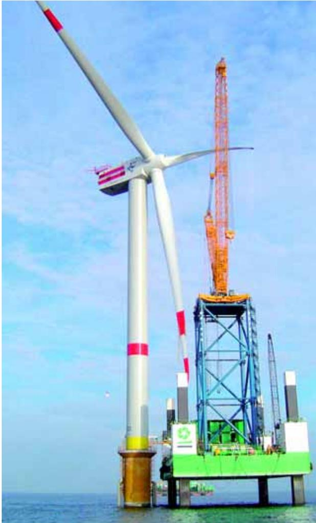
**Offshore-Montage: Da erst nach und nach spezielle Kranschiffe für die WKA-Errichtung auf See entstehen, behilft man sich mit abgewandelten Mobilkrankonzepten.**
