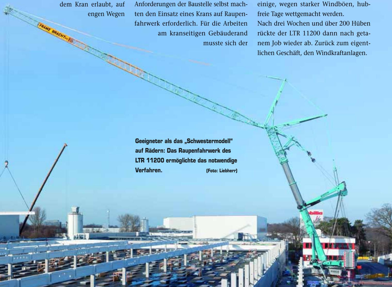
**Geeigneter als das „Schwestermodell“ auf Rädern: Das Raupenfahrwerk des LTR 11200 ermöglichte das notwendige Verfahren.** (Foto: Liebherr)
