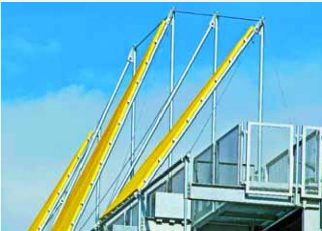
**Windfang:** Auf der obersten Etage wurden gelbe Sonnensegel aus Streckmetall in 100 speziell angefertigten Stahlfedern aufgehängt, die das Schwingen der Segel bei Wind auffangen.
