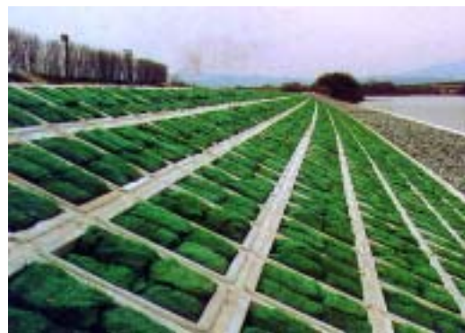
施工後初期風貌
