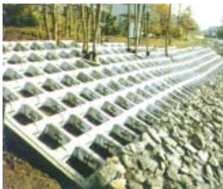
方框格樑堤岸施工狀況
