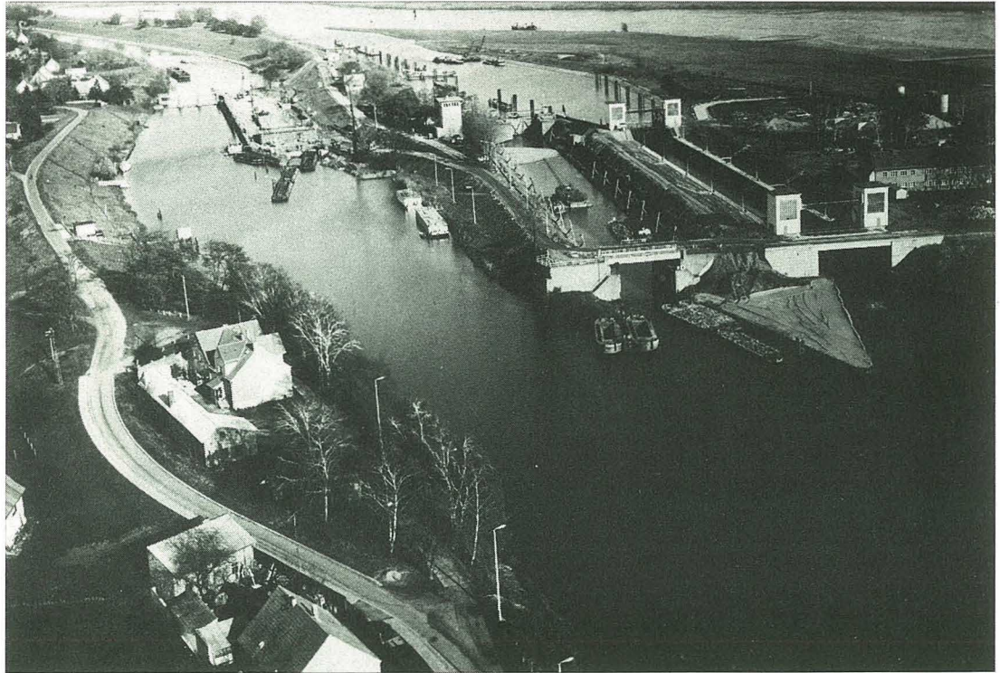
Bild 4 Baustellenübersicht mit betriebsbereiter neuer Ostschleuse (LFB 503/90/984/86/69)
