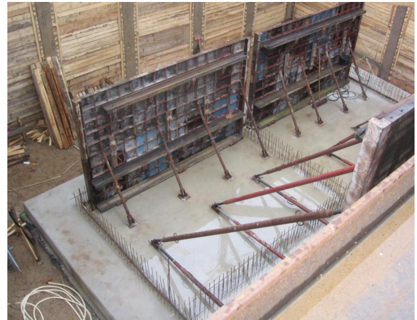
Sporn an Bodenplatte zur Aufnahme Bodenauflast
