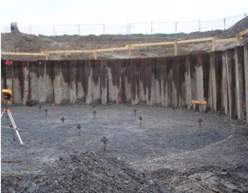
Zugpfähle in Bodenplatte zur Rückverankerung
