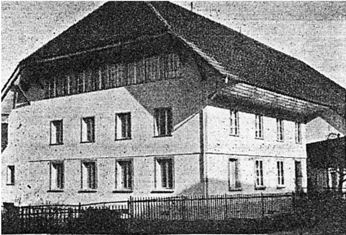
Das Bauernhaus Scheurer-Tschamper in Brittnau nach der Renovation.
