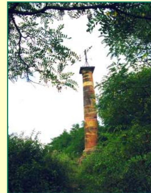
Schiffahrtssäule auf dem Burgberg in Rothenburg
