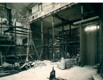
La Maison de Verre (1928-1932) de Pierre Chareau y Bernard Bijvoët, implicó también la reforma de una estructura existente. Hubo que apelar el piso superior con una estructura metálica, usada luego como soporte de la casa. Un muro de bloques de vidrio difunde la luz natural y oculta las vistas del interior en doble altura, de modo similar a como ocurre en el espacio principal del Roca Gallery.
