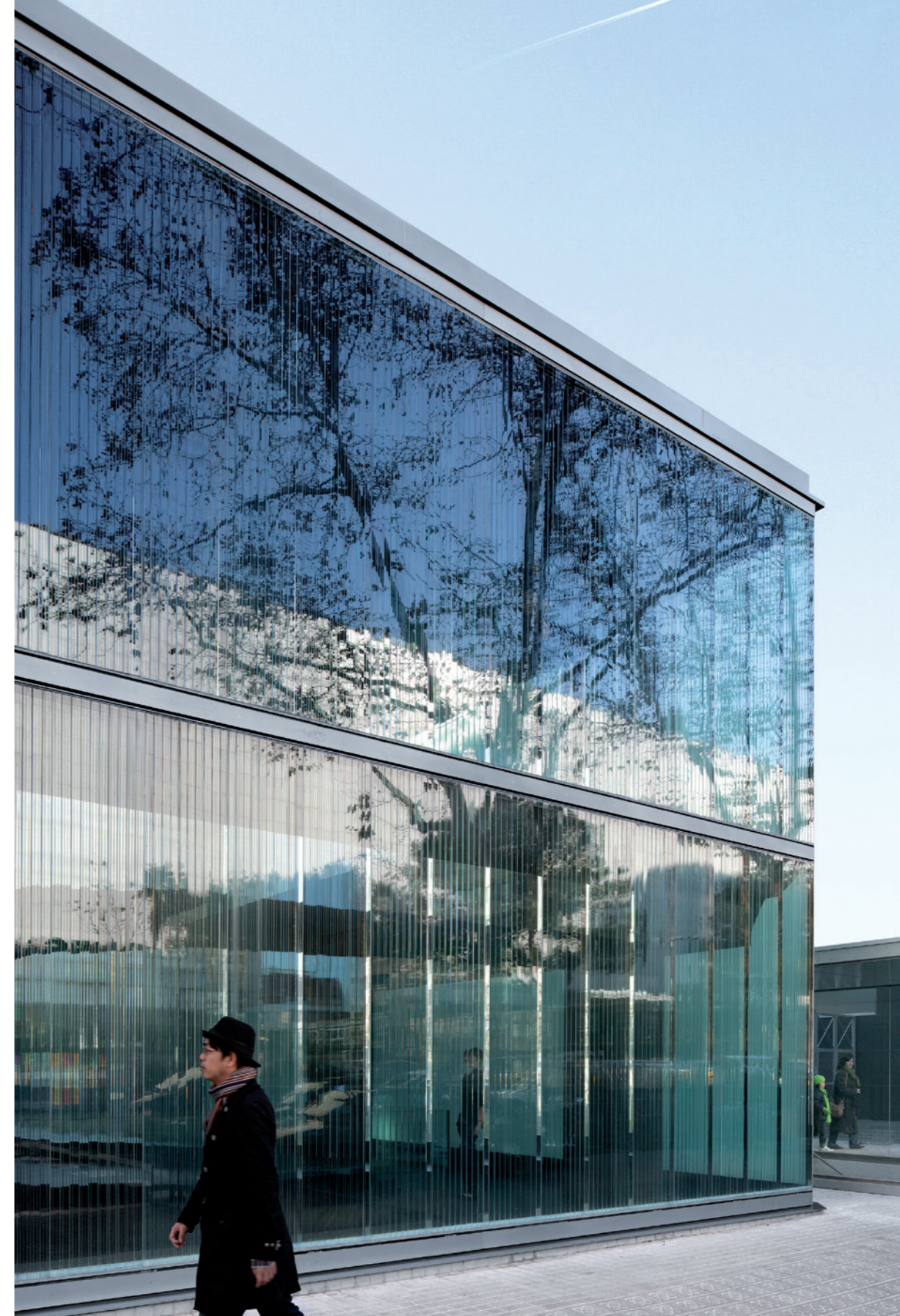
La materialidad vítrea de su fachada enlaza este proyecto con hitos del pasado, como son la Glashaus y la Maison de Verre: al doblar sus esquinas el edificio entero se convierte en un muro vítreo, haciendo desaparecer tanto el edificio como su contenido, como anunciaba Scheerbarth en su texto, Glasarchitektur (1914).
