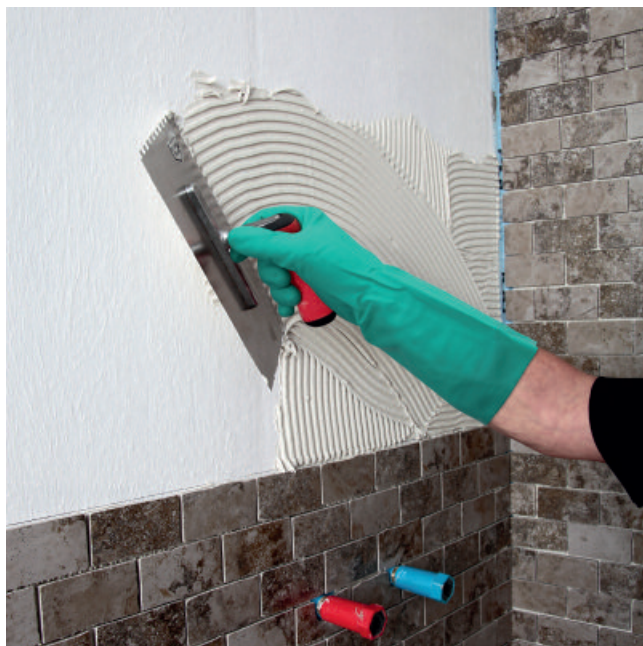
6. Nach Trocknung der PCI Lastogum-Dichtschicht können Fliesen und Platten verlegt werden.
