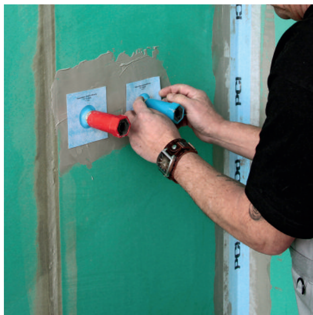
2. PCI Pecitape 10 x 10 über den aus der Wand herausstehenden Rohranschluss stülpen und mit PCI Lastogum (grau) verkleben.
