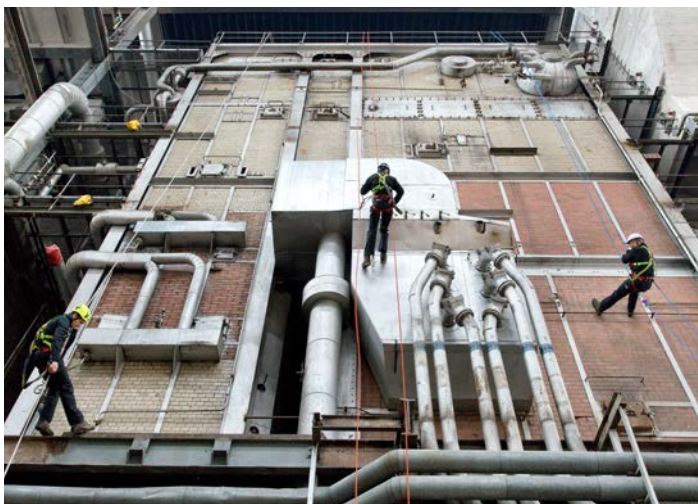
Der Kessel des alten Kohlekraftwerks bietet eine einmalige Location.
