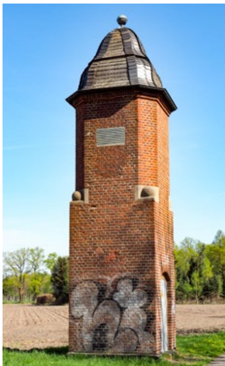
Transformatorstationen Hinterm Hagen
