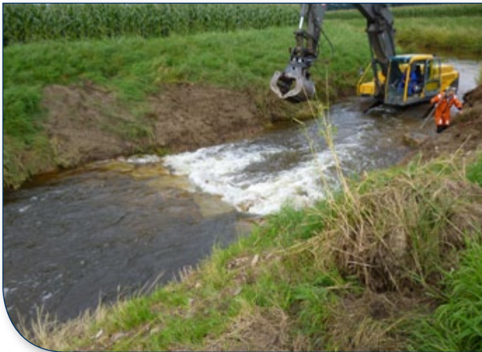
Umbau eines Sohlabsturzes an der Vechte im August 2015 – während der Bauphase.
