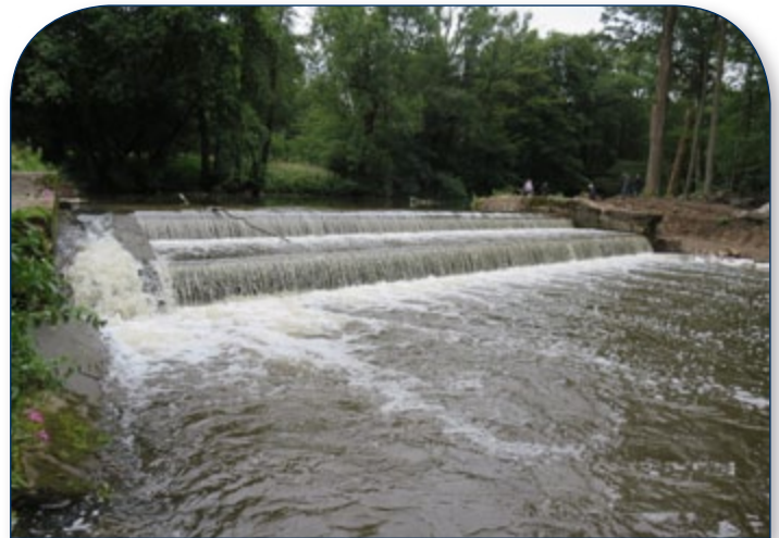
Die Wehranlage vor dem Umbau.
