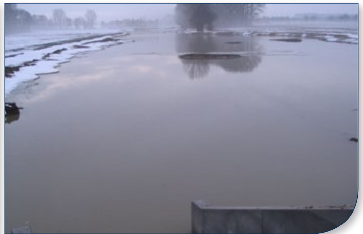
Sinnvolle Maßnahme: Einstau an der Sekundäraue Welse 2011.
