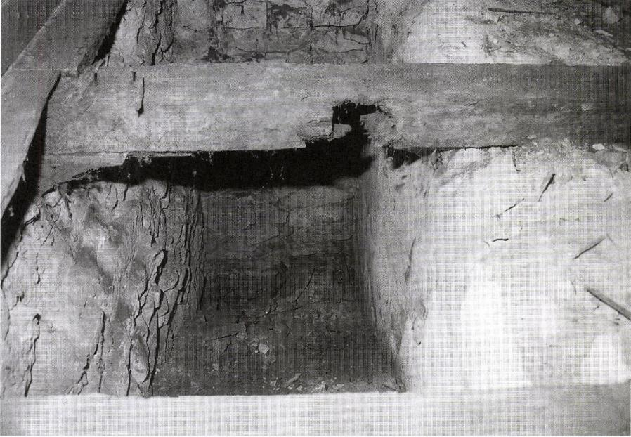
*Abb. 3: Blick in das bei der Erneuerung des Fußbodens im Speisesaal des Herrenhauses im April 2005 freigelegte Loch, das links die bei der um 1830 erfolgten Erweiterung des Hauses entstandene Bruchsteinmauer und rechts die ursprüngliche mittelalterliche Außenwand des Kellergeschosses erkennen läßt.*
