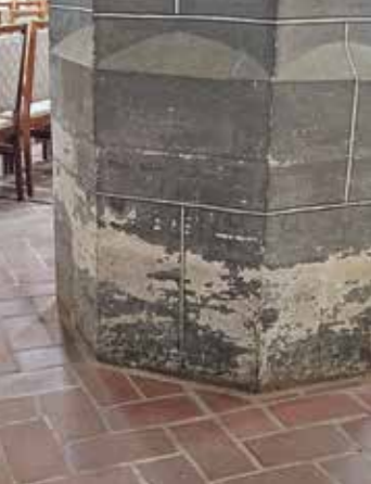
Durchfeuchtete Säulenfüße Notgesicherte Gewölberippe ▼ Beschädigtes Taufbecken
