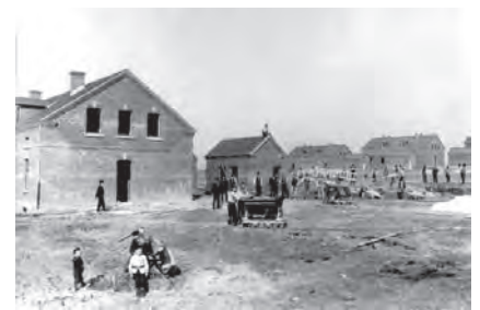
Stemmersberg: Baustelle Hüttelstraße 1900; Quelle: www.oberhausen-osterfeld.de
