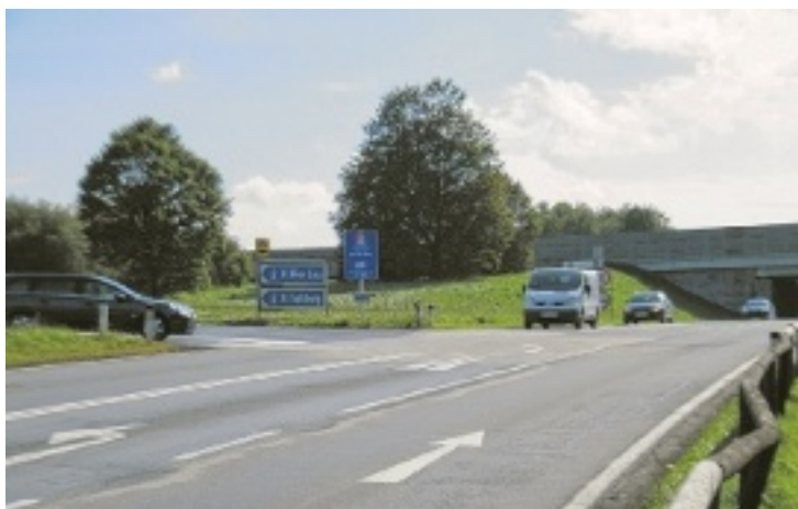
Im kommenden Jahr wird an der B145 mit dem Bau des Kreisverkehrs begonnen.
