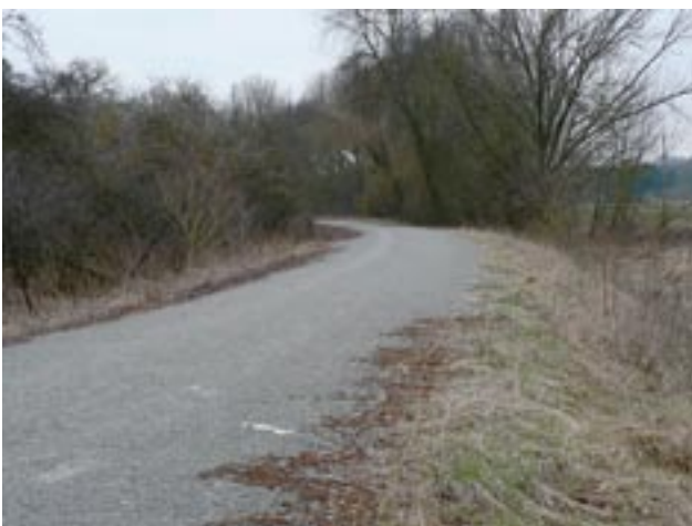
Abbildung 3: Radweg auf einem ehemaligen Bahndamm nördlich der Stadt Seßlach im Landkreis Coburg mit gut verdichteter Feinsplittdecke.
