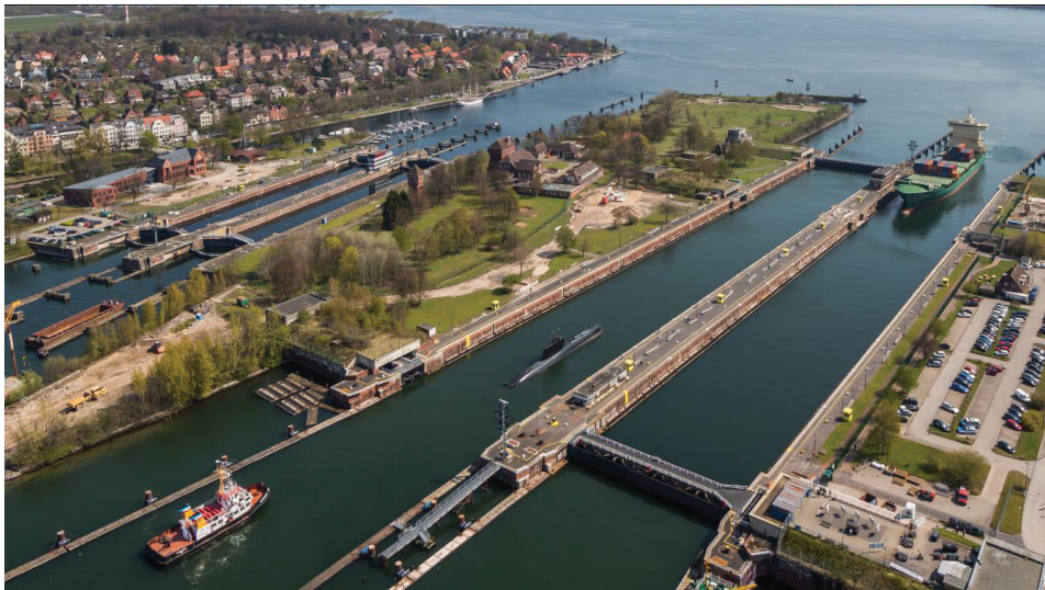
Bild 1: Schleusenanlage Kiel-Holtenau, Von v.r. Große Schleuse, Kleine Schleuse, Auslasskanal mit Auslassbauwerk. (Quelle: Luftbildservice Bernot)
